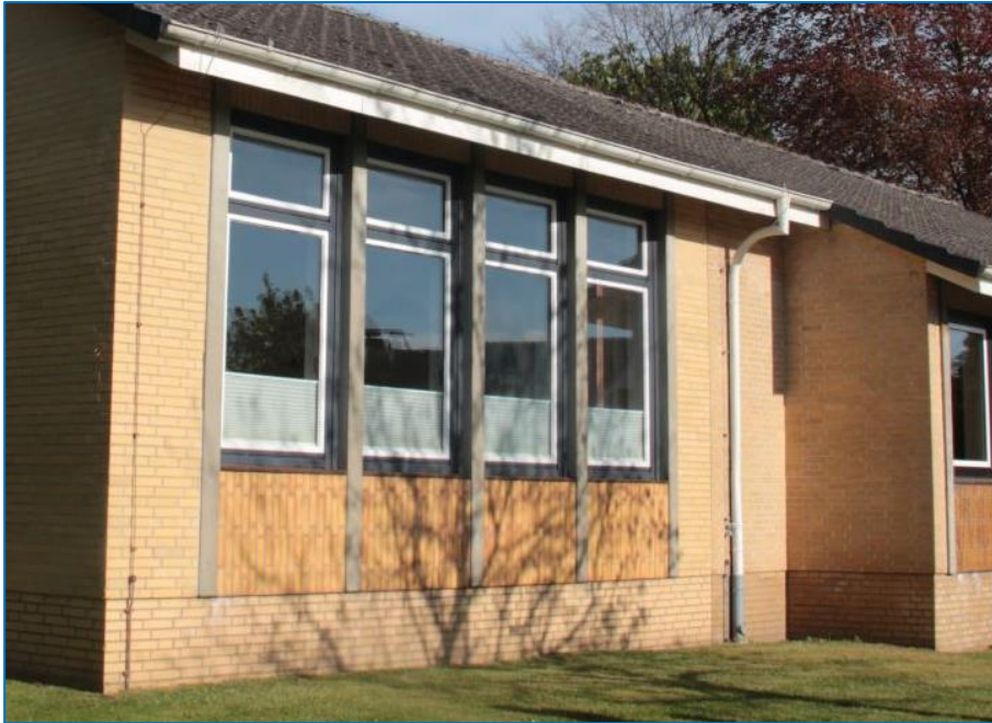
Abb. 18: Auszutauschende Fensterkonstruktion
