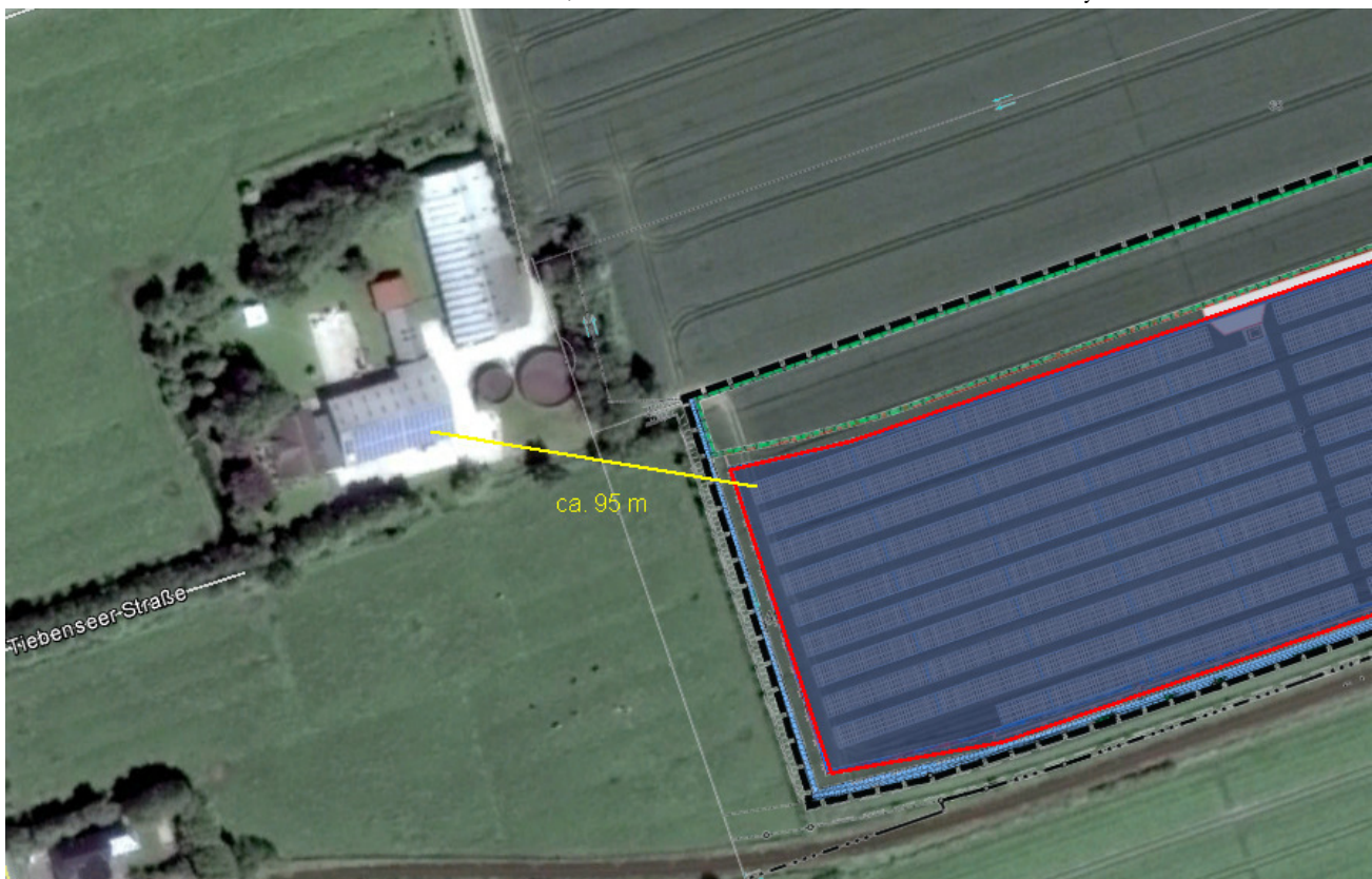
Bild S4: Gebäude im Westen der PV Anlage (Quelle: Google Earth / SolPEG)
