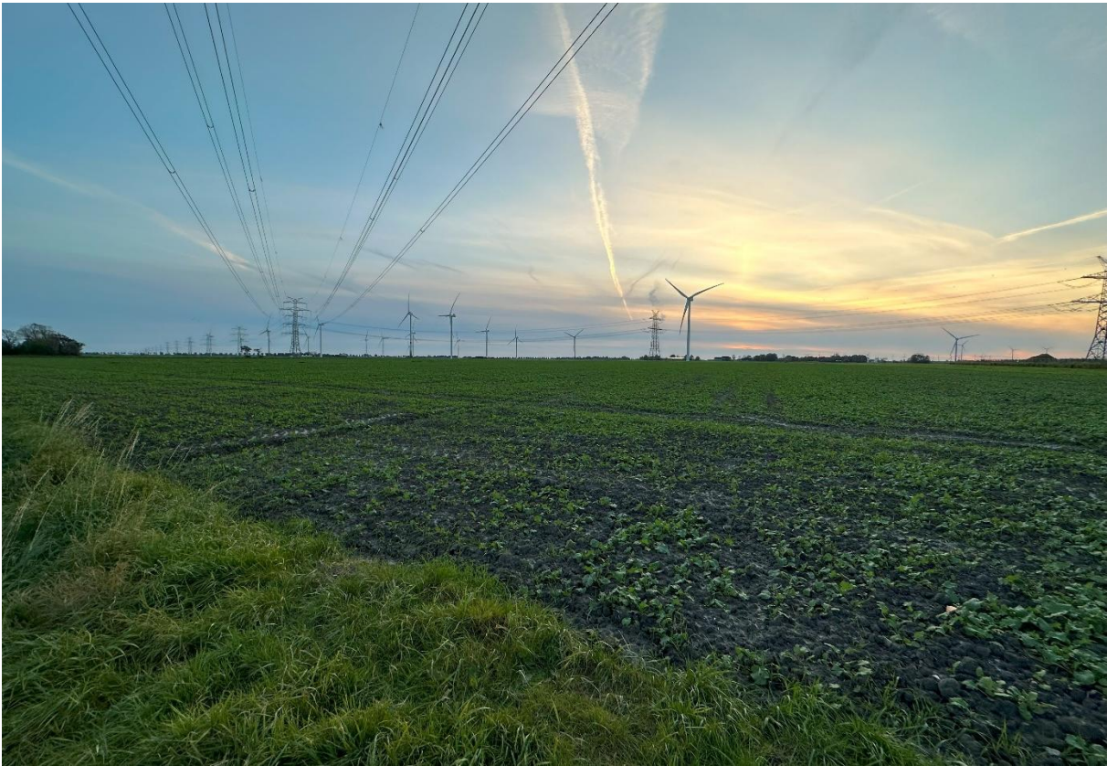
Abbildung 4: Plangebiet südlich zum Umspannwerk, Blick in Richtung Südwesten (Kyon Energy, 2023)
